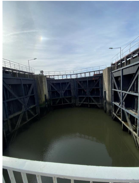
Abbildung 5: Schleuse am Eidersperrwerk (eigene Aufnahme 25.09.2023)
